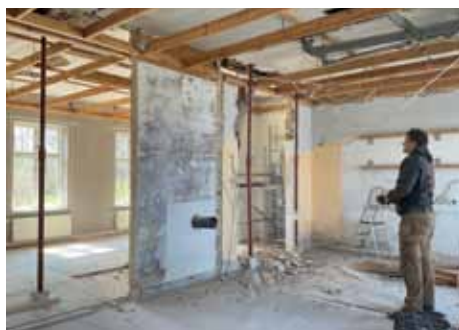
Alrum, køkken og stue er nu lagt sammen og klar til at blive bygget op igen.
